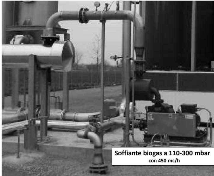
Soffiante biogas a 110-300 mbar
