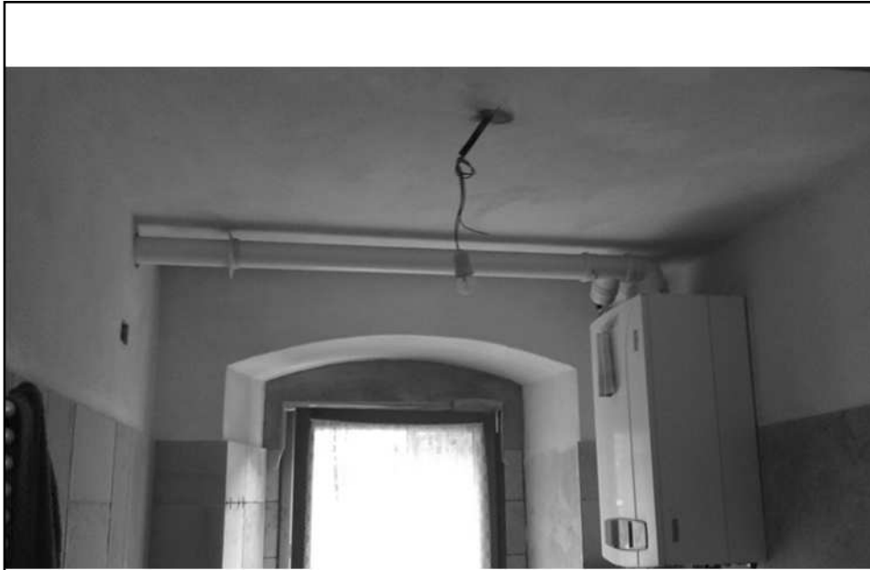
Rischi correlati e semiotica degli incendi in presenza di impianti termici e sistemi di accumulo
