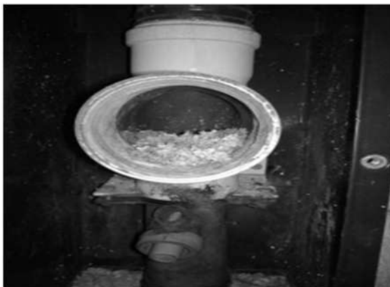
Rischi correlati e semiotica degli incendi in presenza di impianti termici e sistemi di accumulo
