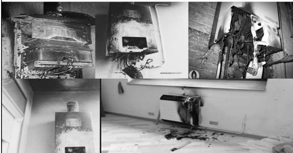
Rischi correlati e semiotica degli incendi in presenza di impianti termici e sistemi di accumulo
