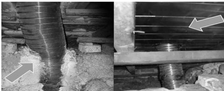
Rischi correlati e semiotica degli incendi in presenza di impianti termici e sistemi di accumulo
